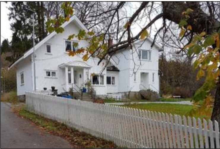
Figur 25: Bebyggelse i strøket: Høytorp gård, som ligger langs Høgliveien, inntil planområdet.
